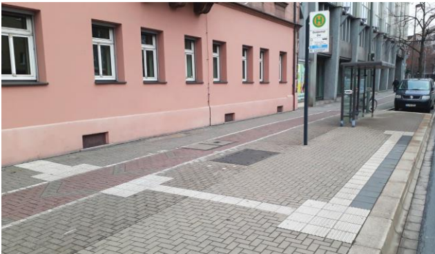
Abb. 26: Haltestelle Gostenhof Ost, Nürnberg Flächen mit Bodenindikatoren gelten für blinde und sehbehinderte Menschen als sichere Bewegungs- und Aufenthaltsbereiche. Daher dürfen auf Flächen wie z. B. Radwegen keine taktilen Bodenindikatoren verlegt werden. Der Auffindestreifen wird an obiger Haltestelle daher durch den querenden Radweg unterbrochen. Der Radweg verläuft hinter dem Fahrgastunterstand. Aufgrund einer Vorgabe der Stadt Nürnberg befindet sich auch an Tür 2 ein zweites Einstiegsfeld, welches durch einen Leitstreifen mit dem Einstiegsfeld an Tür 1 verbunden ist. Zwischen Leitstreifen und Sonderbord wurden dunkle Platten verlegt (Kontraststreifen).
