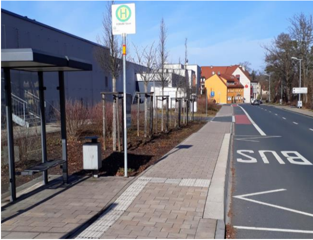
Abb. 17: Haltestelle Stein Forum, Lkr. Fürth Haltestelle am Fahrbahnrand mit 24 cm hohem Sonderbord mit Spurführung. Durch den Radfahrstreifen im Anfahrtsbereich der Haltestelle gilt ein Halteverbot am Straßenrand. Es können also keine parkenden Autos die – schon weit vor der Haltestelle beginnende – gerade Anfahrt des Busses zum Haltestellenbord behindern.
