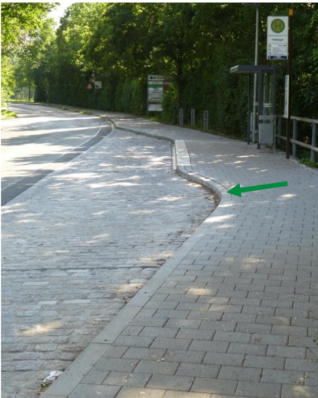
Abb. 18: Haltestelle Stein Fabergut, Lkr. Fürth Die Busbucht mit Nase ermöglicht eine parallele, spaltminimierende Anfahrt des Steiges. Auf Höhe der Einbuchtung (grüner Pfeil) ist der Gehsteig nur 12 cm hoch und kann dadurch leicht überstrichen werden. Im Bereich der 9 Meter langen Aufstellfläche wurde ein 22 cm hohes Sonderbord verbaut.
