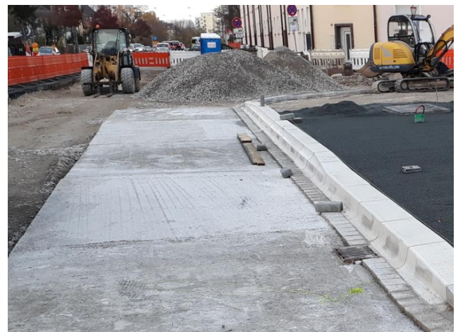
Abb. 19: Haltestelle Wiesenstraße, Fürth Entstehung einer festen, verformungsfreien Fahrschulung durch den Einbau von Betonplatten im Haltestellenbereich im Zuge des barrierefreien Umbaus; anschließend wird die Asphaltenschicht aufgetragen.
