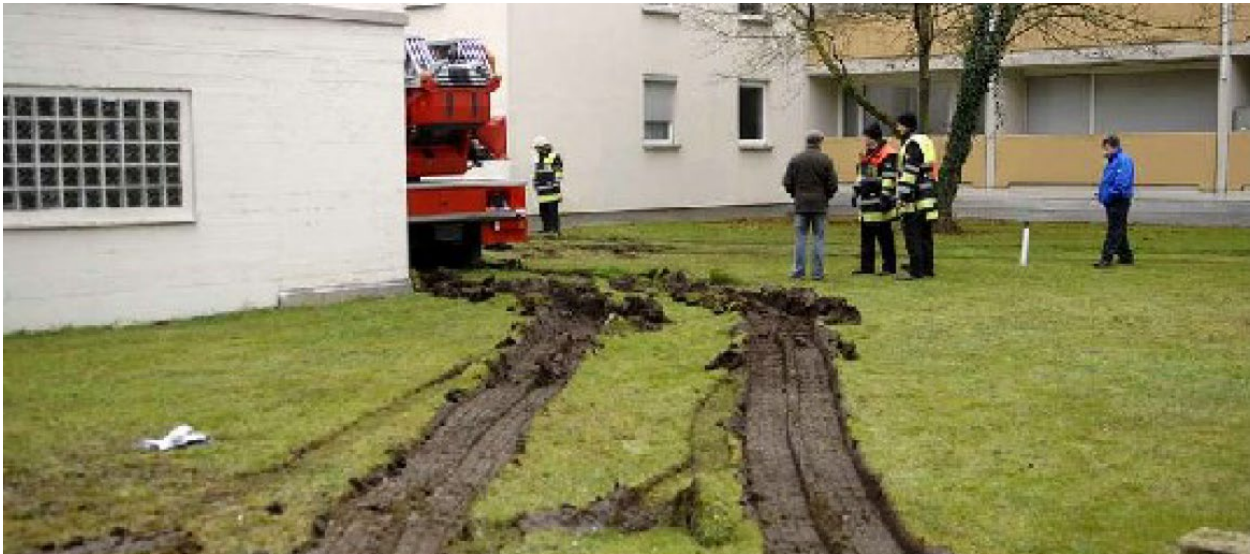
Humusbildung auf den Feuerwehrlflächen ist unzulässig
